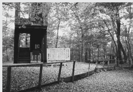
写真は地上15M、解体された展望台
